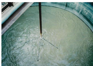
スラリー貯槽
